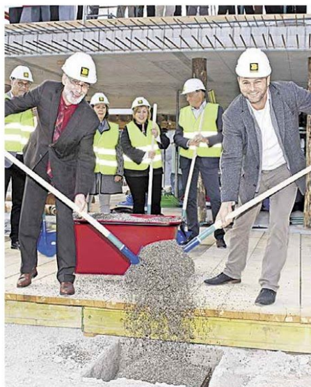
Reto S. Fuchs und Markus Birchmeier decken den Grundstein mit Kies zu.
